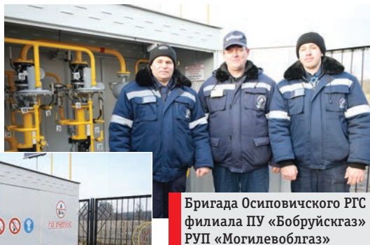
Наземный шкафной газорегуляторный пункт
