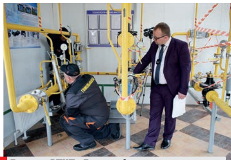
Бригада РПУП «Гомельоблгаз» выполняет практическое задание «Пуск газа в сезонно работающий ГРП»
