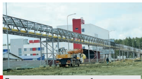
Построен внутриплощадочный газопровод протяженностью порядка 4 км к производственным цехам завода «БЕЛДЖИ»
