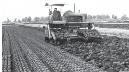
Производство торфа кускового, 1960 год. Укладка кускового торфа змейкой
