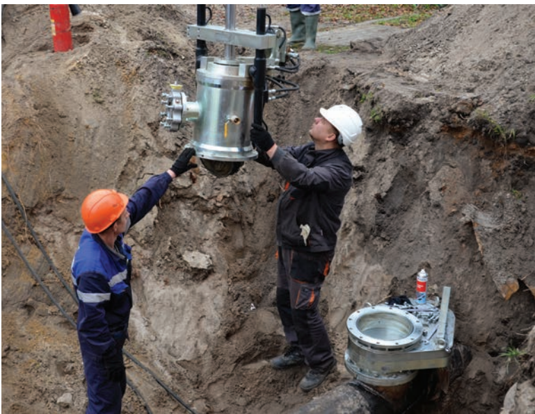
Ремонт сетей газоснабжения с применением оборудования «Стоп-система»
