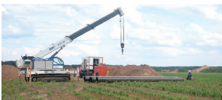
Идут работы по переустройству участка магистрального газопровода-отвода «Слоним – государственная граница Литовской Республики»
