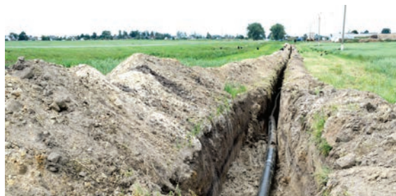
В д. Гольичи идут работы по укладке газопровода
