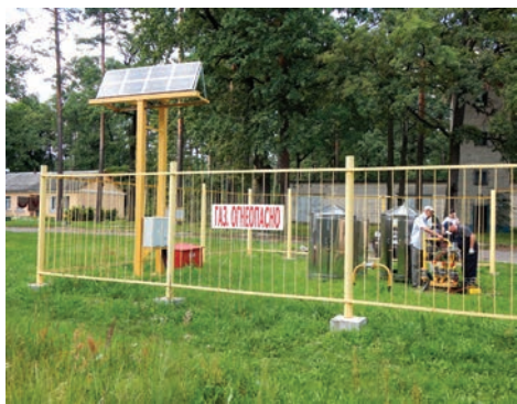
Газорегуляторные и шкафные регуляторные пункты, групповые емкостные установки оснащаются энергосберегающими системами телеметрии, позволяющими значительно снизить затраты на электрификацию и эксплуатацию объекта
