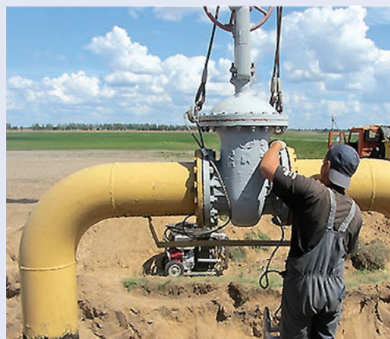
Сегодня на предприятии активно используется стоп-система, дающая возможность перекрытия газопроводов диаметром от 57 до 300 мм включительно
