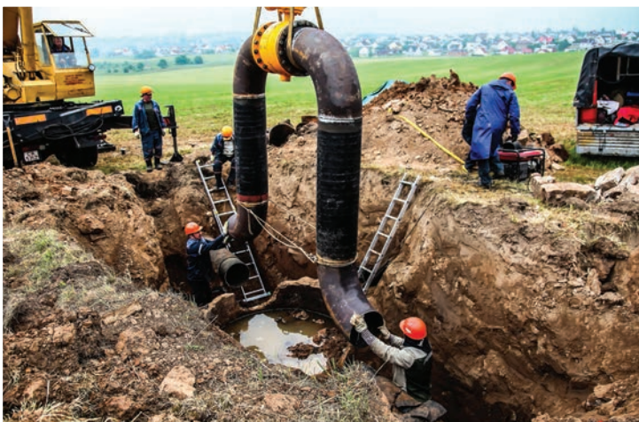
Замена запорной арматуры на подземном газопроводе в г. Новогрудке
