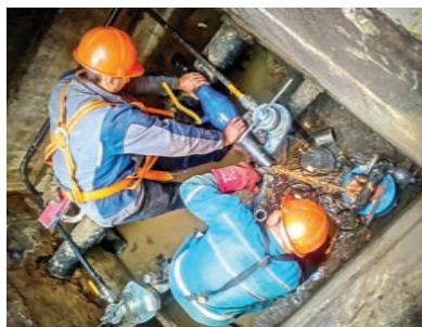
Производство работ на газопроводе с использованием стоп-системы Ravetti
