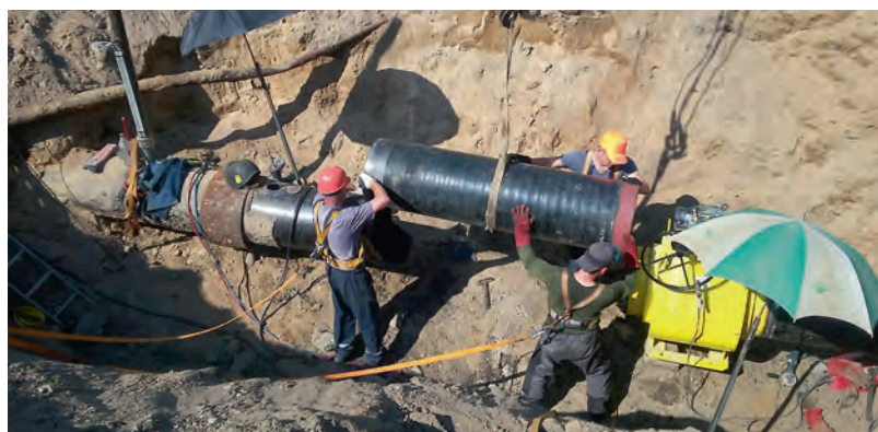
Замена отключающей арматуры диаметром 700 мм, г. Минск
