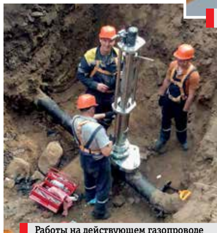
Работы на действующем газопроводе ведутся с использованием системы Ravetti
