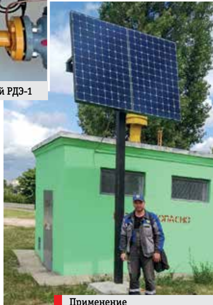
Применение фотогальванических батарей для электроснабжения ГРП
