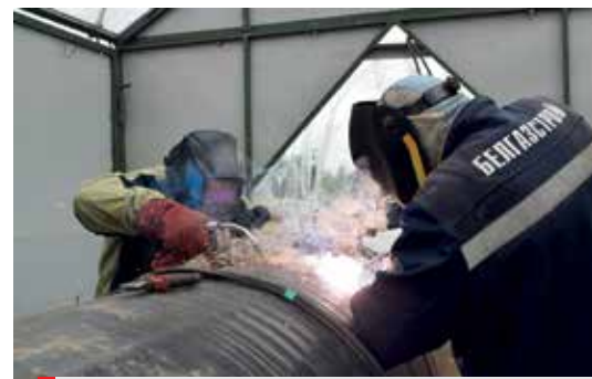
Специалисты ОАО «БЕЛГАЗСТРОЙ-холдинг» выполняют сварочные работы на газопроводе диаметром 800 мм
