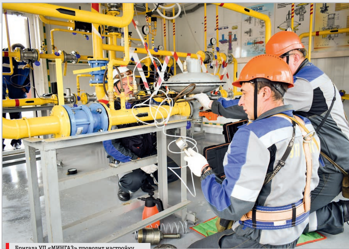
Бригада УП «МИНГАЗ» проводит настройку оборудования после устранения утечки газа
