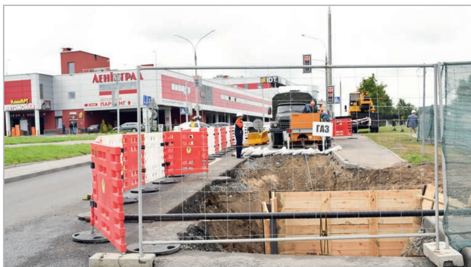
При проведении реконструкции газопровода движение на автомобильной дороге не перекрывалось, а лишь ограничивалось на непродолжительное время. Минимальный размер строительной площадки, отсутствие необходимости применять громоздкую строительную технику – также в числе преимуществ применения технологии санации
